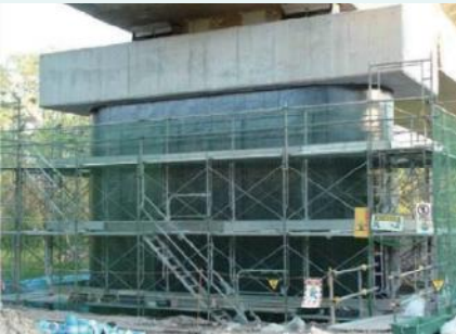
炭素繊維による補強の施工事例
