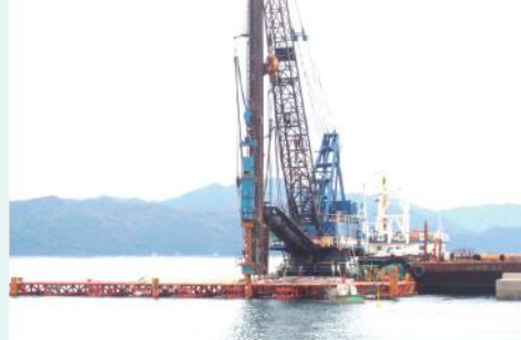
海上での基礎杭の施工事例
