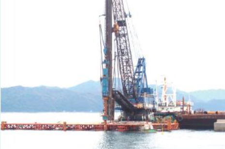
海上での基礎杭の施工事例
