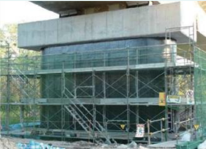
炭素繊維による補強の施工事例
