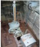
▲農業用放流バルブ 鋼材の孔食等<br>
