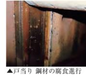
▲戸当り 鋼材の腐食進行 鋼材の孔食等                                                                                                     |
