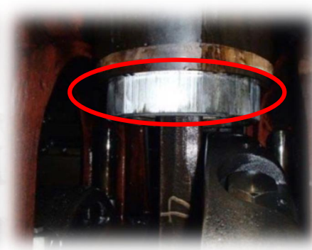
ピストンの損傷状況
