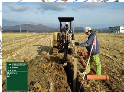
床掘・敷高確認
