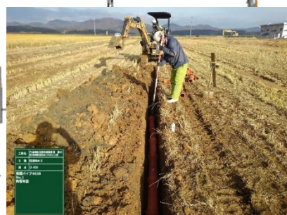
暗渠管(陶管)敷設
