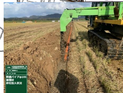
保護碎石投入・敷均
