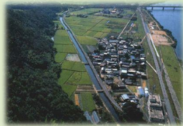
【写真】吉井川地区 大用水路(岡山県)
