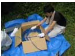
ケーブルの取り扱い、土 などで汚れないよう注意 を払う。
