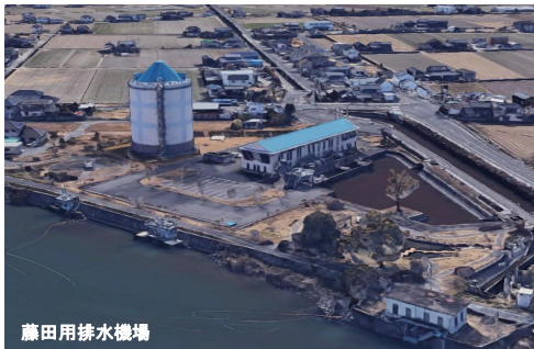
藤田用排水機場
