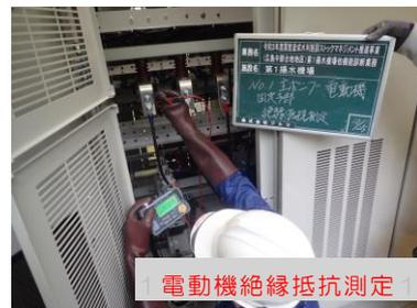
機能診断結果《評価：S5（健全）～S1（劣化）》としては、機場建屋の一部に雨漏り、防水加工の劣化が見られS3評価、ポンプ設備の一部にオイル漏れ、オイルの劣化が見られS4評価、電気設備はS5評価で健全であると診断しました。診断結果については、データベースに登録するとともに、施設管理者等の関係者と情報共有を行います。
