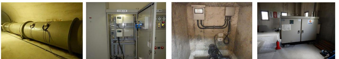
【流速検出器（下蚊屋ダム導水管流量）】【変換器（下蚊屋ダム導水管流量）】 【流量指示計盤（温湯井手取水量）】 【予備発電装置（下蚊屋ダム）】
