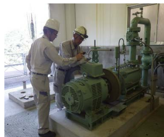
ポンプ設備調査
