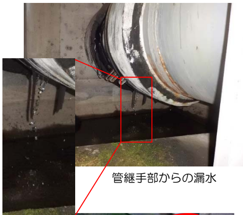
野村ダム取水塔の継手部からの漏水
