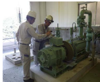
ポンプ設備調査
