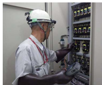
電気設備調査
