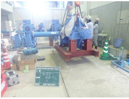
揚水機場搬入・設置
