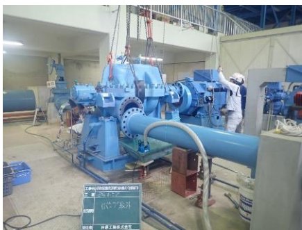
ポンプ取り外し
