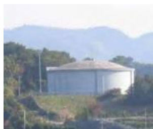
前歴事業で整備された調整水槽
