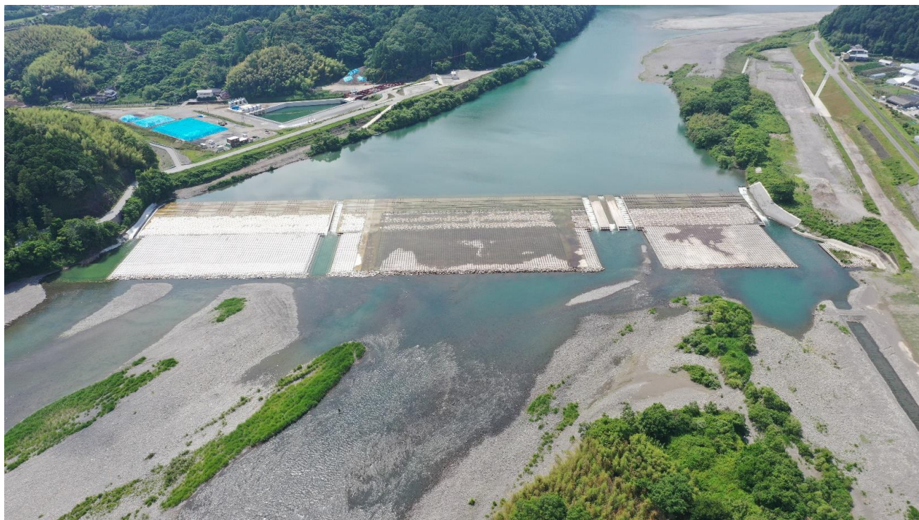
那賀川南岸堰（徳島県阿南市）
