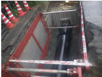
新管布設（DCIPφ600 NS形 2種管）
