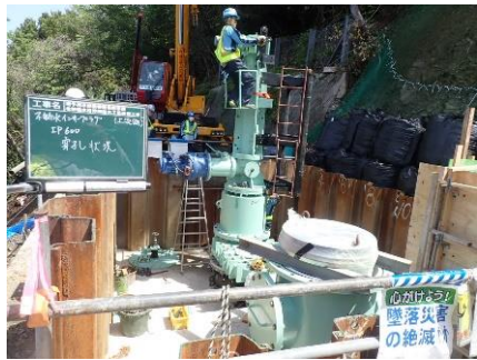
不断水インサープラグ 穿孔状況
