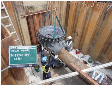
不断水分岐 割T字管吊込
