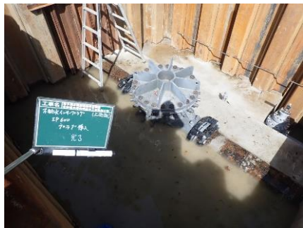
不断水インサープラグ 挿入完了
