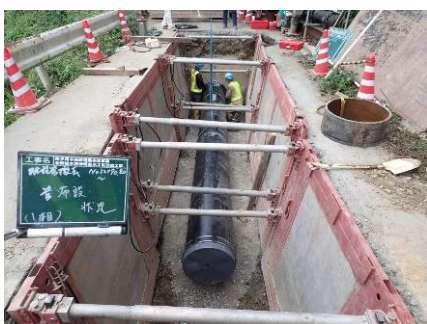
新管布設（DCIPφ600 NS形 2種管）
