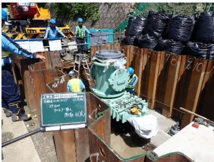
不断水インサープラグ 挿入準備
