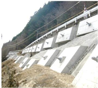
アンカー工（抑止工）
