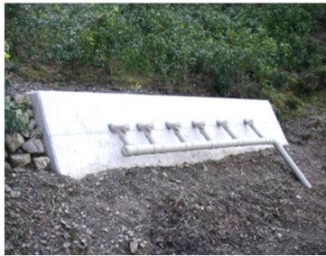
水抜きボーリング工（抑制工）
