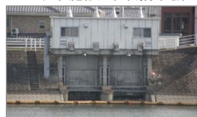
旧取水施設: 川内用水樋門
