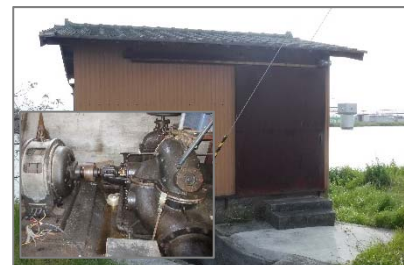
旧取水施設: 中須揚水機
