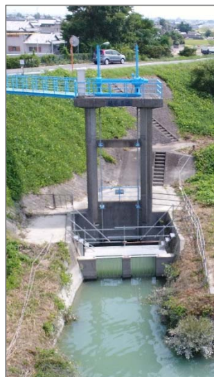
旧取水施設: 板名用水柿島樋門
