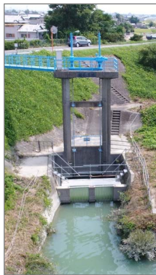
旧取水施設: 板名用水柿島樋門
