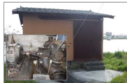
旧取水施設: 中須揚水機
