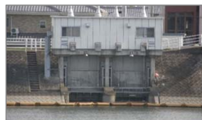
旧取水施設: 川内用水樋門
