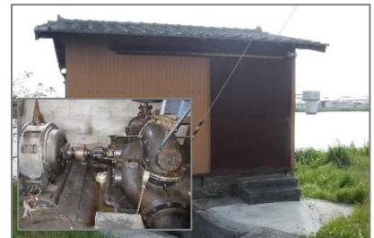
旧取水施設：中須揚水機
