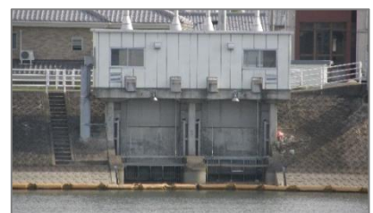
旧取水施設：川内用水樋門
