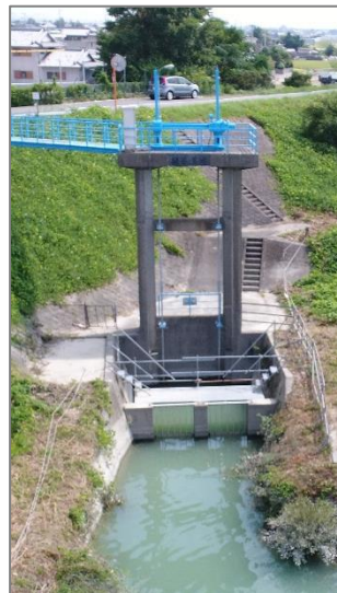
旧取水施設：板名用水柿島樋門
