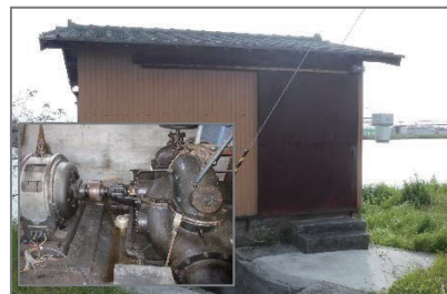
旧取水施設：中須揚水機
