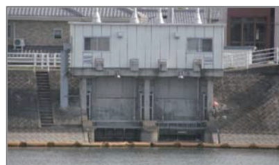
旧取水施設: 川内用水樋門
