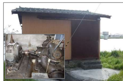
旧取水施設: 中須揚水機
