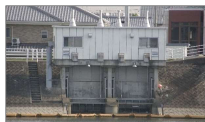
旧取水施設：川内用水樋門
