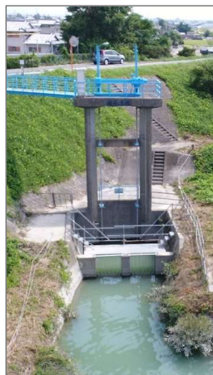
旧取水施設：板名用水柿島樋門
