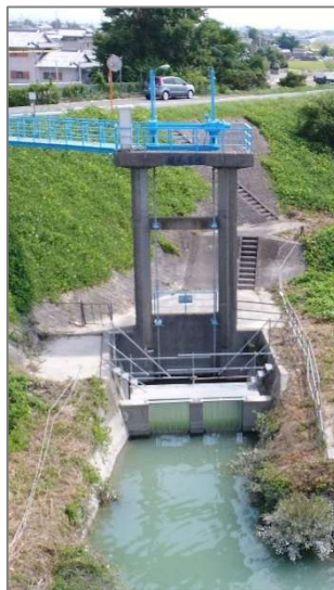
旧取水施設: 板名用水柿島樋門
