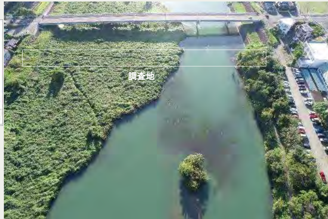
調査地を下流から撮影
