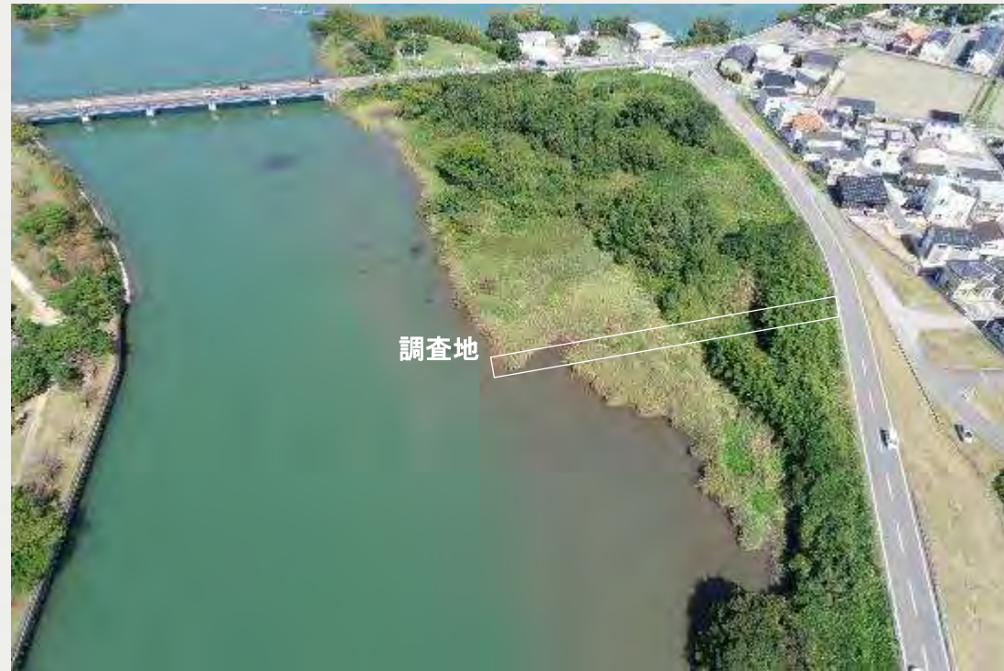
調査地を下流から撮影
