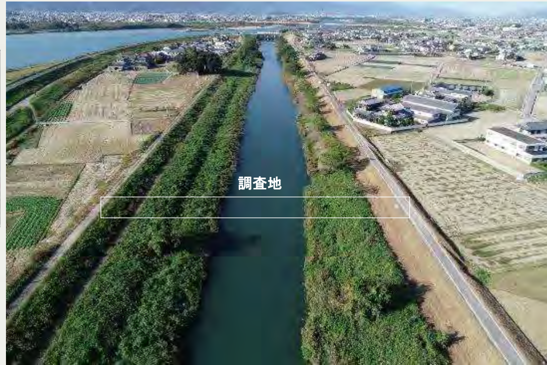
調査地を下流から撮影
