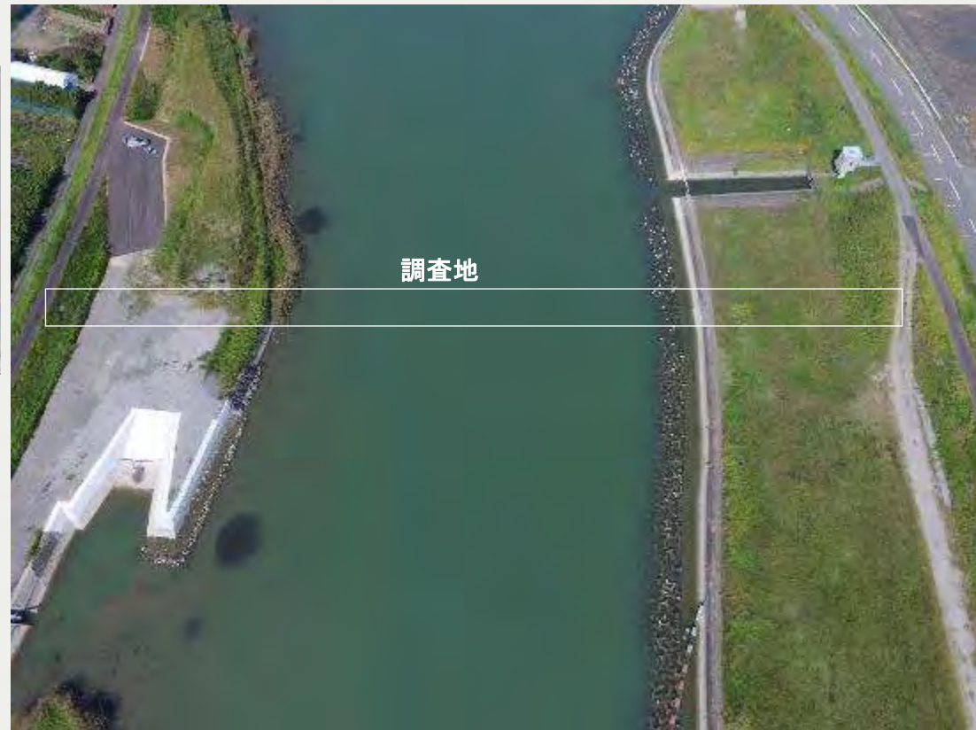
調査地を下流から撮影
