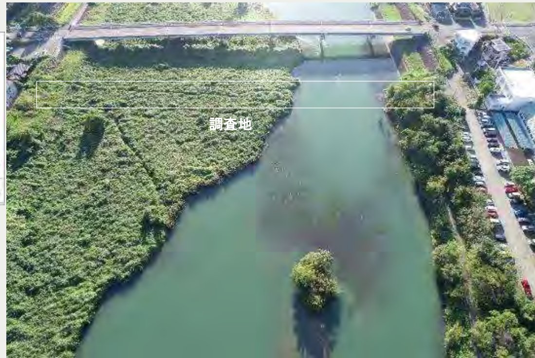
調査地を下流から撮影
