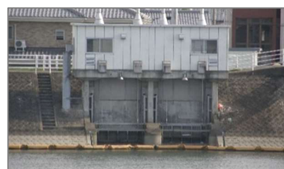
旧取水施設：川内用水樋門
