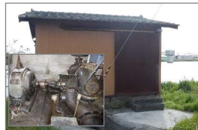
旧取水施設：中須揚水機
