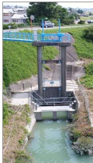
旧取水施設：板名用水柿島樋門
