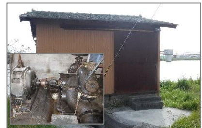
旧取水施設: 中須揚水機
