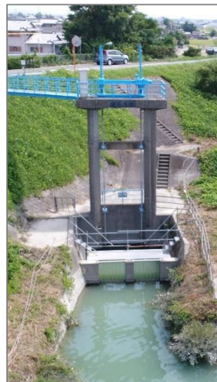
旧取水施設: 板名用水柿島樋門
