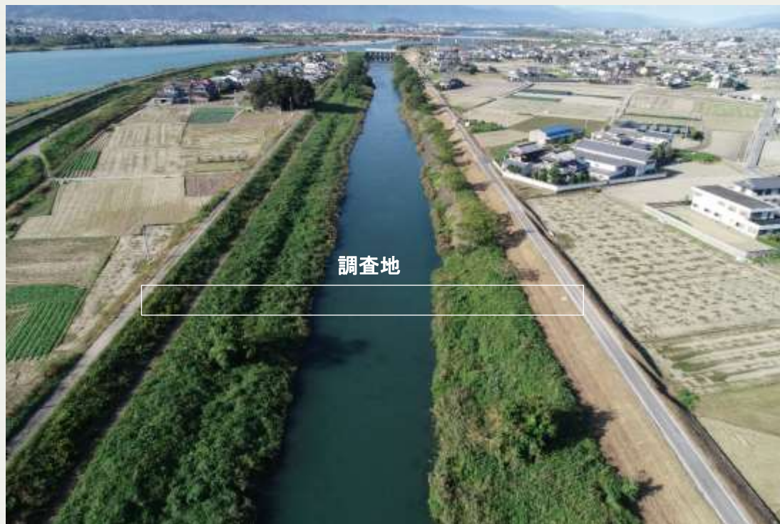
調査地を下流から撮影
