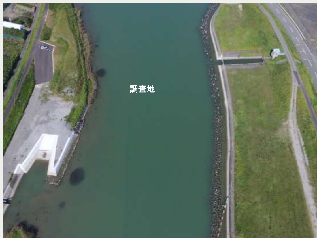
調査地を下流から撮影
