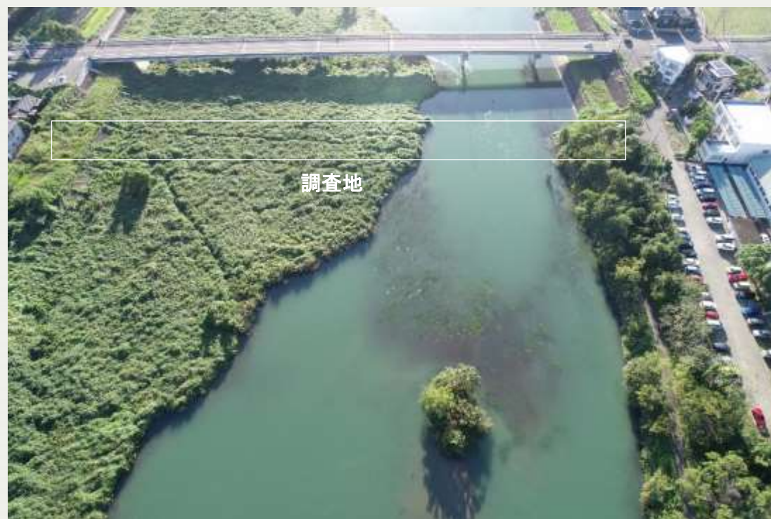
調査地を下流から撮影
