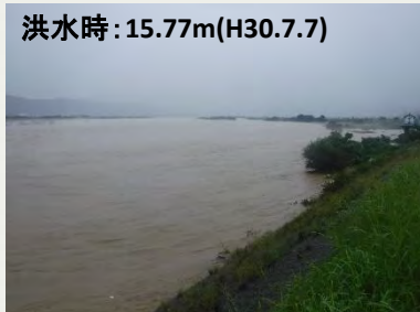
柿原堰左岸下流より撮影
