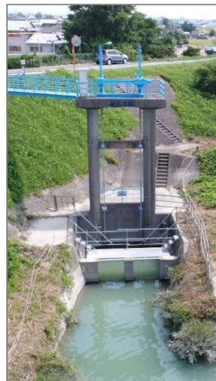
旧取水施設: 板名用水柿島樋門
