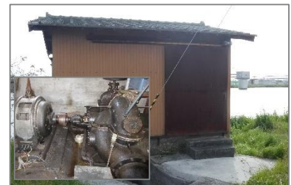
旧取水施設: 中須揚水機
