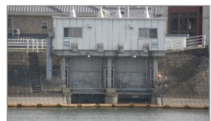
旧取水施設: 川内用水樋門
