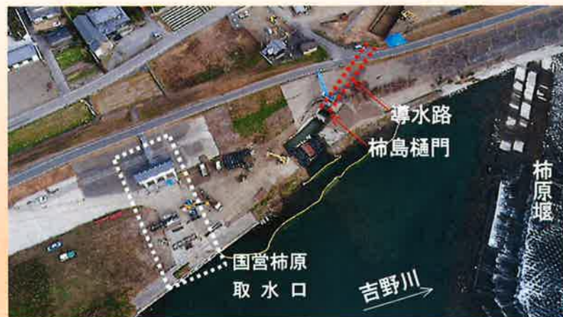
上空から見た柿島樋門・導水路周辺の現況
