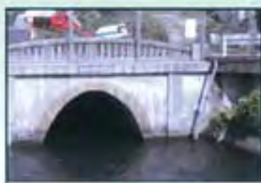
撤去前の「柿原大暗きよ」
