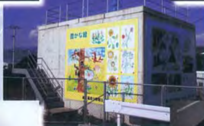
幹線水路管理施設： 上板町
