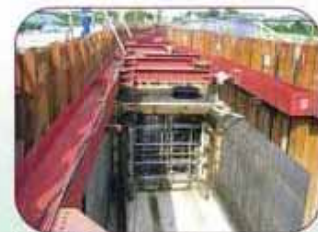
【板野町日出家地区】 地表を掘削して行う箱形水路工事 （内空断面：2.6m×2.6m）
