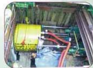
【藍住町富吉地区】 黄色の機械がモグラのように地中を掘り進む推進工法 （管水路の内径：φ2.0m）
