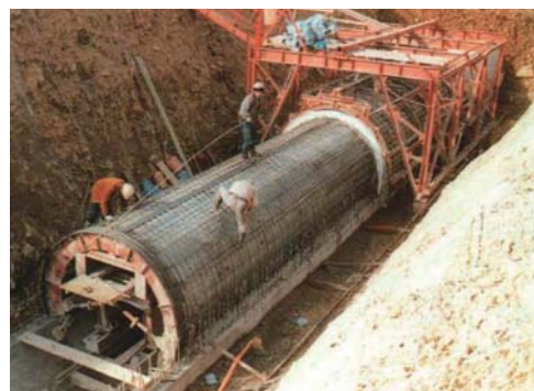
ひらきぐち 日開谷サイホン（工事中）
