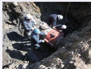
老朽化した管の補修
