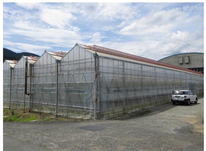
再建したミニトマト栽培施設
