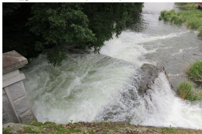
放水口から水が勢いよく流れる
