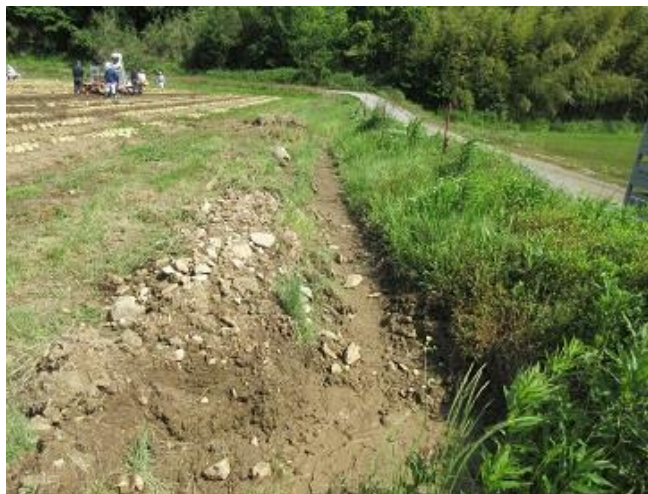
排水対策のため、ほ場の周囲に施工された明渠
