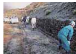
農道側溝の土砂上げ
