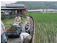
水路の泥上げ
