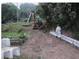
機能診断により水路フリーユームの布設替えを実施
