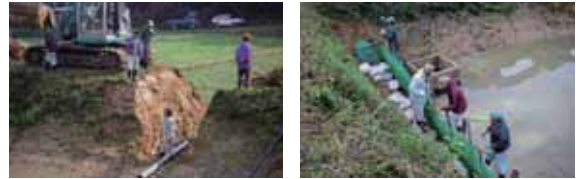
堤体底種の改修
