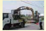
重機のリースにより除草
