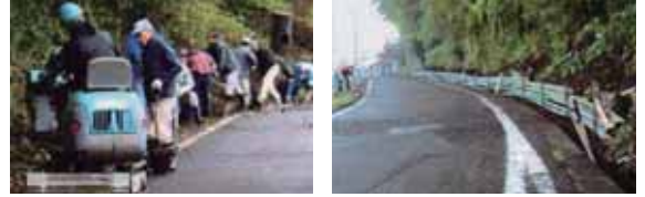
路肩・法面の土留め柵設置
