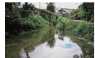
工事後の状況
