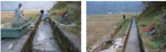
水路の側面補強及び目地詰め
