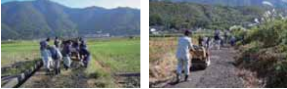
農道の窪みにサイクルアスファルトを入れ踏み固めた
