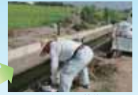
水路法面の補修
