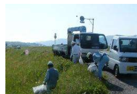
異物等の除去状況(例)
