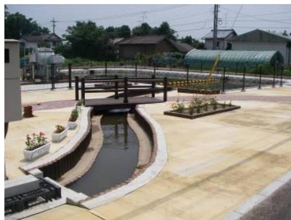
▲せせらぎ水路のある親水施設(原鹿南揚水機場)
