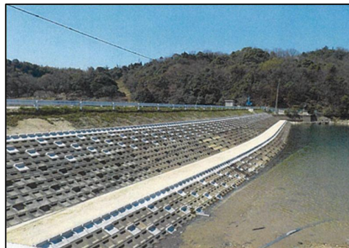
▲打越上池(丸亀市)の施工の様子
