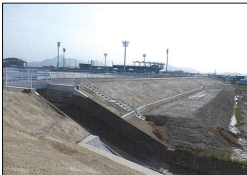
▲先代池(丸亀市)の施工の様子
