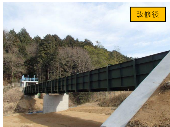
▲水路橋改修（天川導水路：西川水路橋（耐震設計・鋼製））
