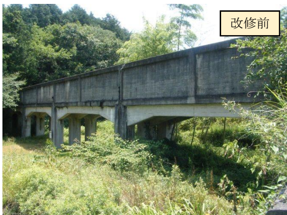
▲水路橋改修（天川導水路：西川水路橋（耐震設計・鋼製））
