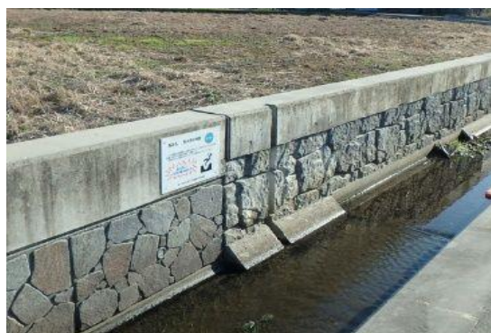
▲土砂溜・角落し
