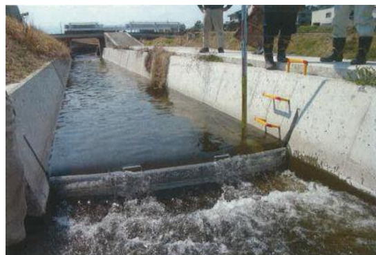
▲角落しに堰板を設置した様子
