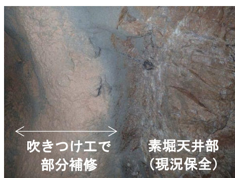
▲一部モルタル吹き付けした 天川トンネル
