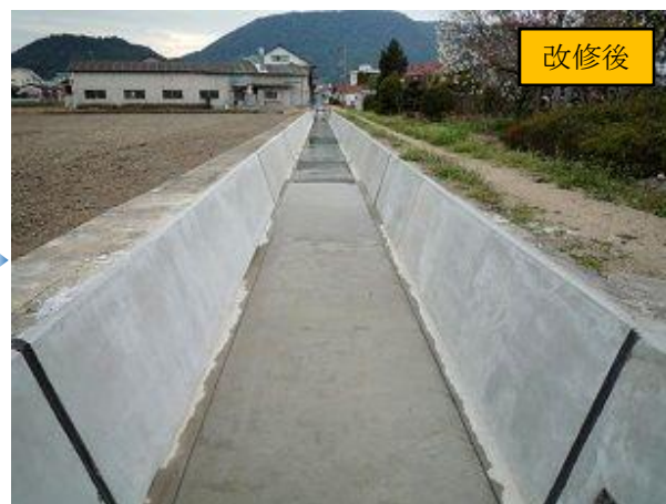
▲開水路改修（五條幹線水路 側壁：無機系被覆工法、底版：コンクリート打替）
