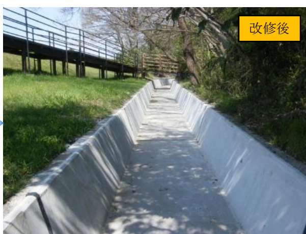
▲開水路改修（飯野幹線水路（下流） 側壁：無機系被覆工法、底版：パネル工法）
