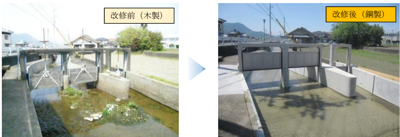
▲ゲート改修工事（木製→鋼製）
