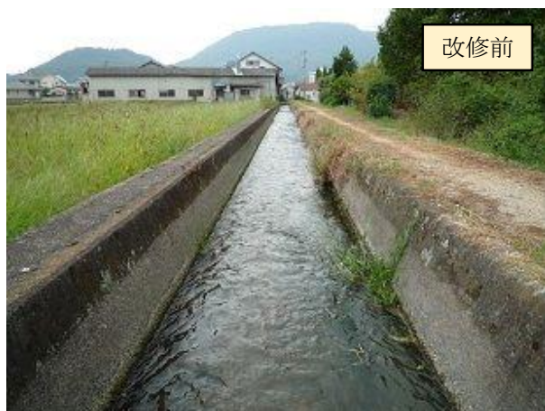
▲開水路改修（五條幹線水路 側壁：無機系被覆工法、底版：コンクリート打替）
