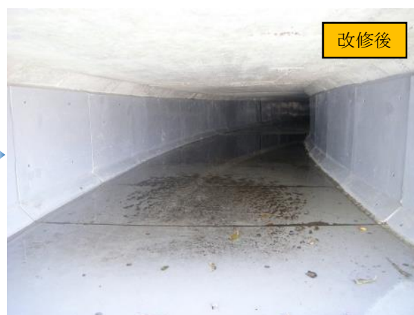
▲暗渠部改修（飯野幹線水路（下流） 側壁・底版：パネル工法）
