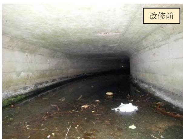
▲暗渠部改修（飯野幹線水路（下流） 側壁・底版：パネル工法）
