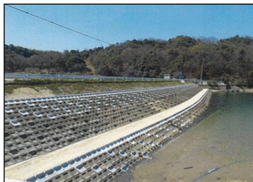
▲打越上池(丸亀市)の施工の様子
