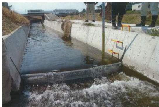
▲角落しに堰板を設置した様子
