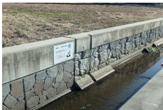
▲土砂溜・角落し
