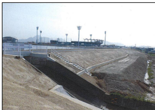
▲先代池(丸亀市)の施工の様子
