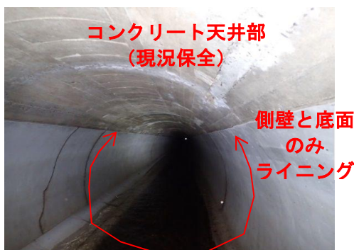
▲天井部を残して改修した 田畑トンネル
