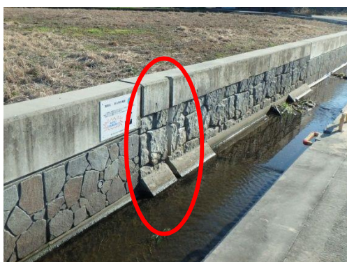
▲蓮池幹線水路（角落し）
