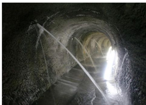
地下水排除状況
