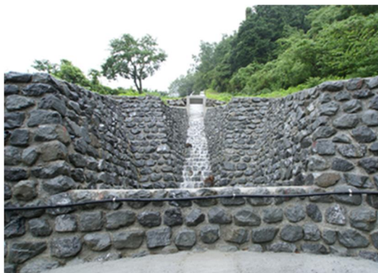
周辺景観との調和に配慮した水路整備
