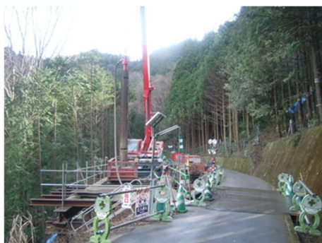
工事中（鋼管建込）
