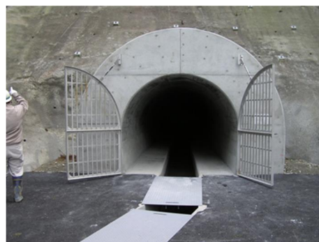
トンネル出口
