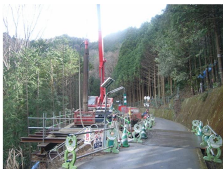
工事中（鋼管建込）
