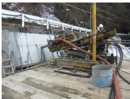
工事中（削孔）
