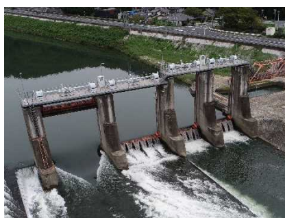
▲高梁川合同堰
