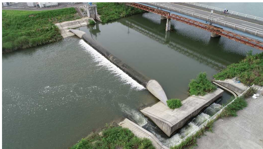
▲改修後の汎樋堰
