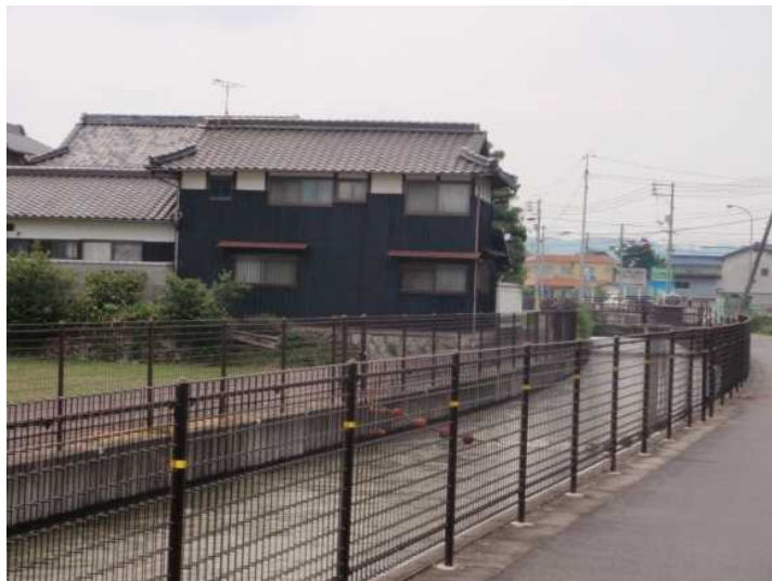
▲周辺景観に配慮した色彩の安全柵
