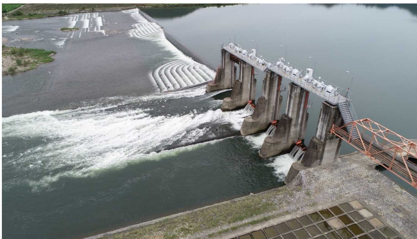
写真：高梁川合同堰
