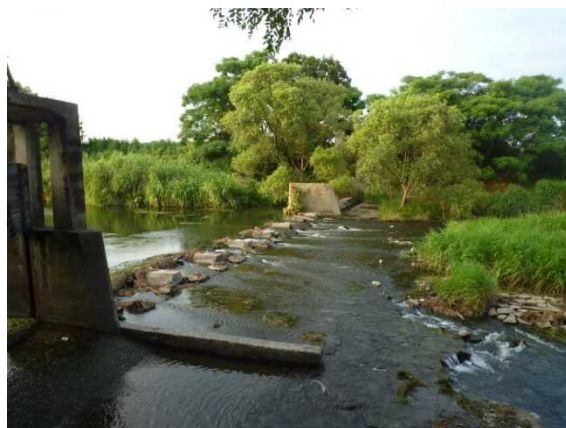
坎樋堰 改修前
