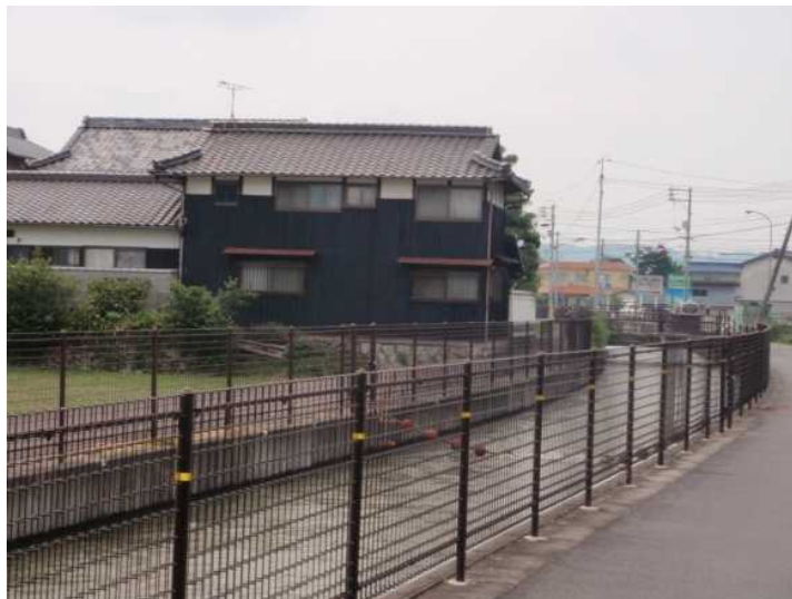
▲周辺景観に配慮した色彩の安全柵
