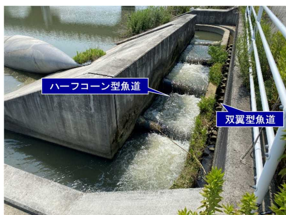
▲ 堰樋に整備された魚道
