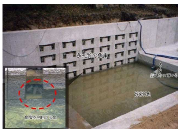
▲魚巢ブロック及び沈砂池
