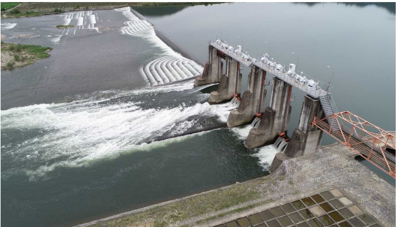
写真：高梁川合同堰
