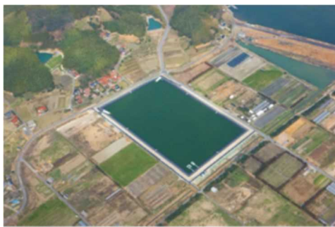
▲安来工区 地区内調整池
