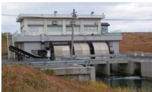
▲揖屋排水機場
