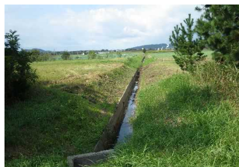
▲排水路（揖屋工区）
