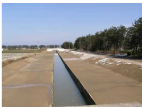
▲ 揖屋幹線排水路
