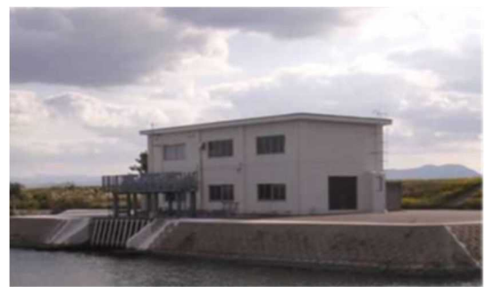
▲弓浜排水機場
