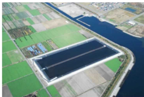
▲弓浜工区 地区内調整池
