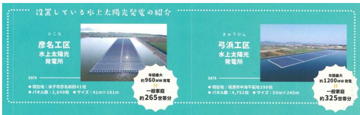
▲調整池に浮かべられた太陽光パネル（彦名・弓浜工区）
