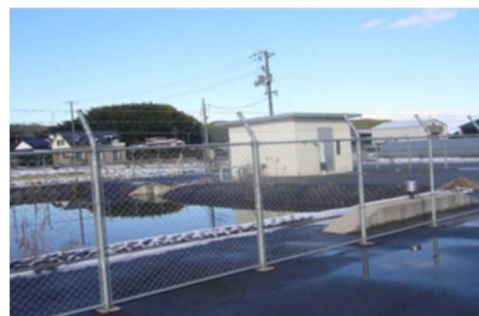
▲伊川用水機場
