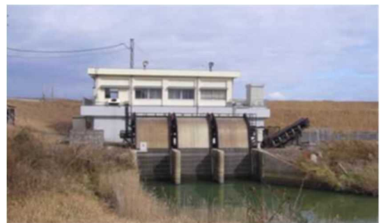
▲安来排水機場
