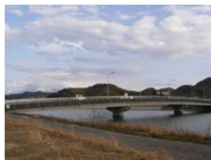
▲安来工区 平田橋（中海橋）
