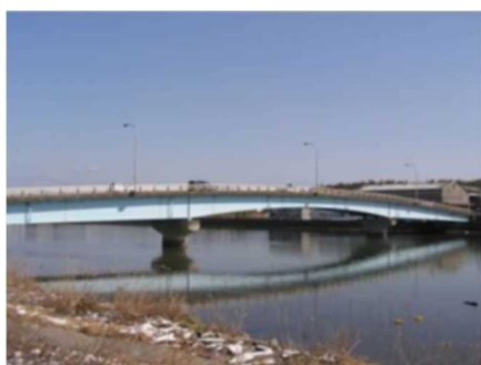
▲揖屋工区 意東橋（崎田大橋）
