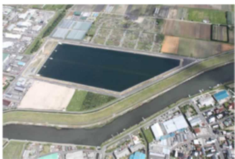
▲揖屋工区 地区内調整池
